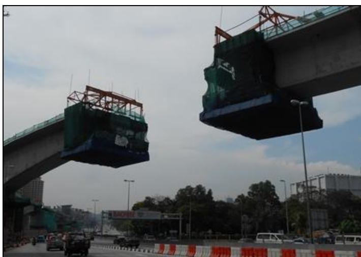
Plet RE-2 Contoh pembinaan span panjang di Laluan SBK
