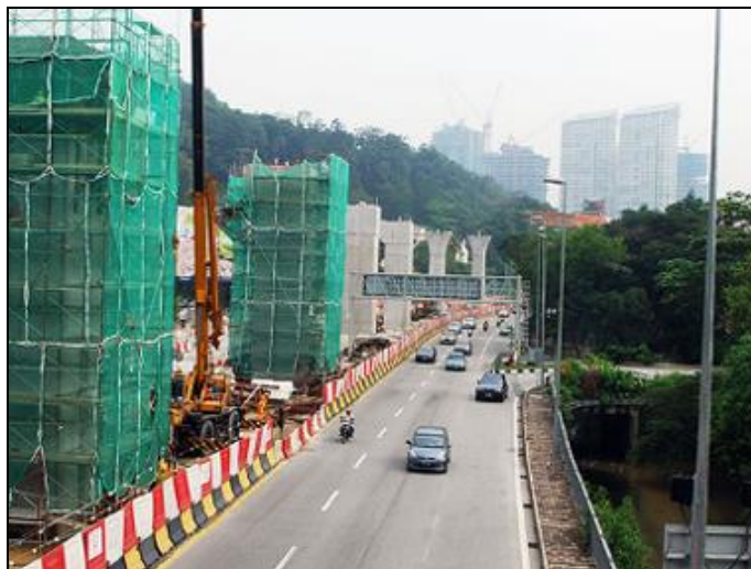
Plet RE-1 Contoh pembinaan pier di bahagian median jalan untuk Laluan SBK
