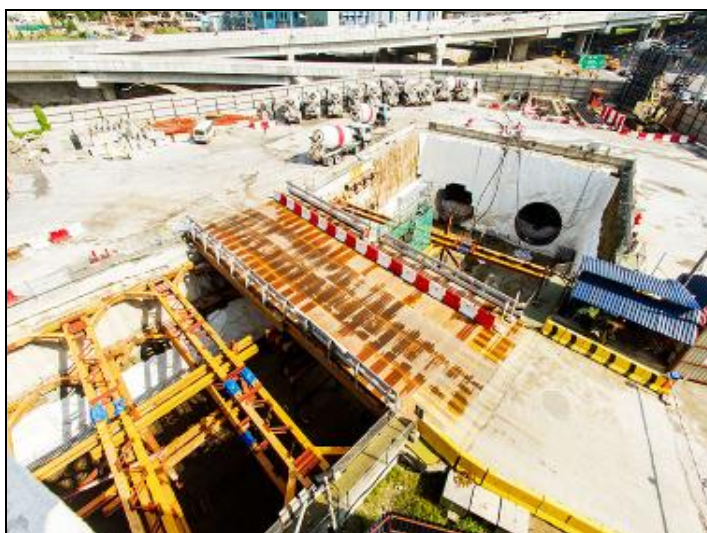
Plet RE-4 Contoh retrieval shaft untuk Laluan SBK (Maluri Portal)
